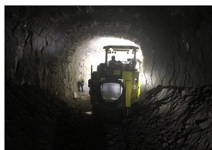
每个孔直径108mm，孔与孔之间只有几厘米，还不能相互打穿，这叫“掏心眼”。中心孔周边是十几个辅助孔，这些辅助孔都要有一定的角度，才能保证获得较好的爆破效果。为了提升作业的精确性，技术部门进行了多次“头脑风暴”，准备尽可能详尽的技术资料，安排技术人员随时跟班，根据岩石较为破碎松软和井下环境等情况不断调整技术和施工方案，以便取得较好的爆破效果。
