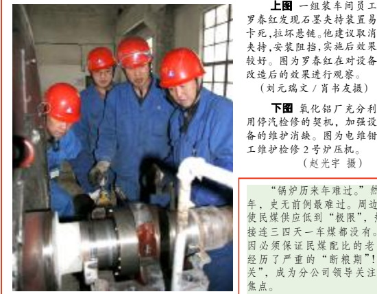
下图 氧化铝厂充分利用停炉检修的契机, 加强设备的维护检修。图为电维钳工维护检修2号炉压机。
