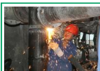
氧化铝厂十分注重对生产设备、工艺流程管网的消缺、优化,通过恢复设备、管网的性能实现铝铝的稳产高产。图为焊工在焊接流程管道。赵光宇 摄
