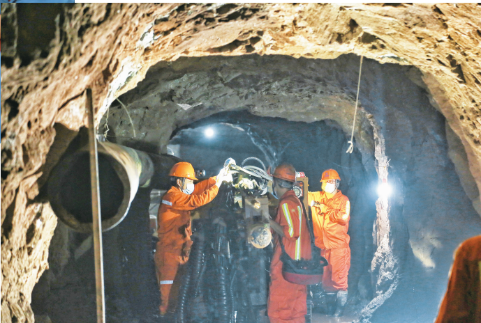
技术人员调试掘进台车,提高井下采矿效率。
