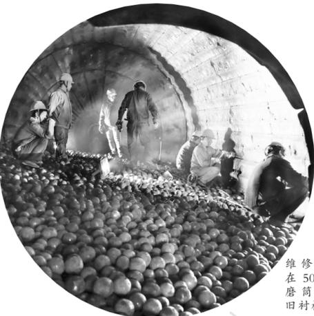
维修人员在5074球磨筒体卸旧衬板。
