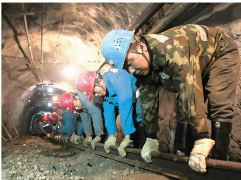
▲职工在井下-320米检修运输铁道,确保井巷运输畅通无阻。
