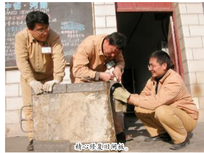
精心修复旧闸板。
