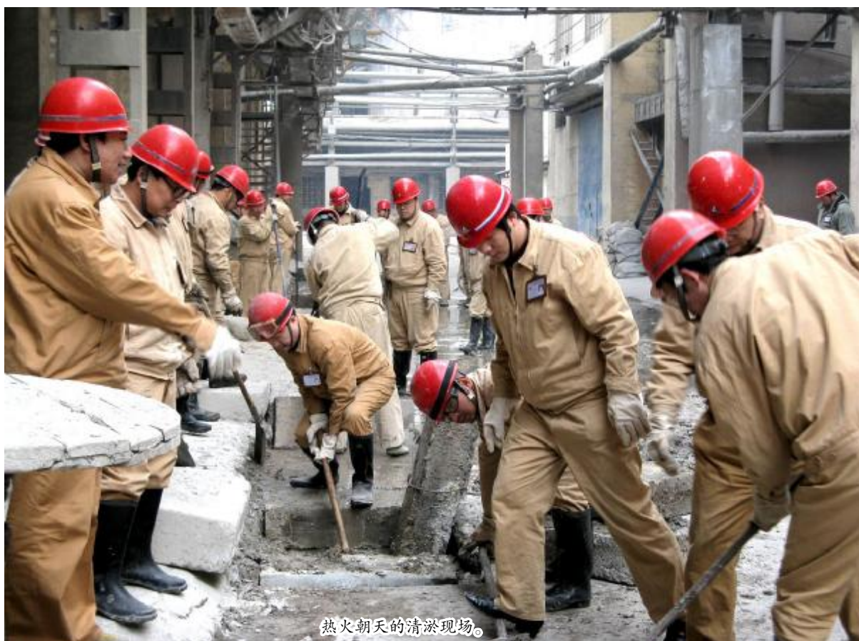
热火朝天的清淤现场。
