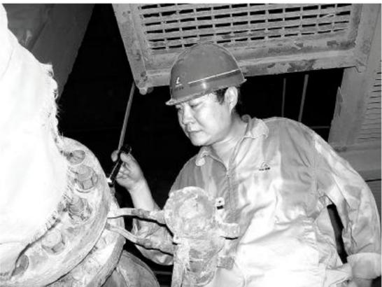
近日,热电厂检修车间员工克服天气炎热和管道高温余热等不利因素,在最短的时间内完成了对3号流量控制板的缺陷检修工作,为热电厂准确计量蒸汽的流量提供了保障。苏志泉 摄影报道
