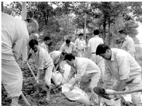
7月19日,连续几日的暴雨给水电厂黄河水源车间安全生产带来了一定的威胁,为防患于未然,车间迅速组织员工对两条爬坡管道周围用沙土袋进行加固。他们仅用1个小时就装了200余袋,为确保分公司稳定用水奠定了基础。高建华 摄影报道
