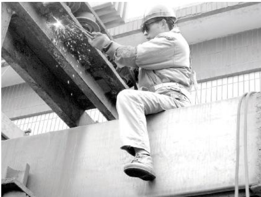
为加强设备管理,水电厂检修车间近日积极推进“延伸点巡检区域”制度,变过去的“故障检修”为现在的“预知维修”新模式,既做到了设备隐患早预防,早发现,早处理,又确保了停电设备保持良好的状态。图为该车间员工正在对整流直降母线瓷瓶进行更换和维护。 张青玉 奚溪 摄影报道
