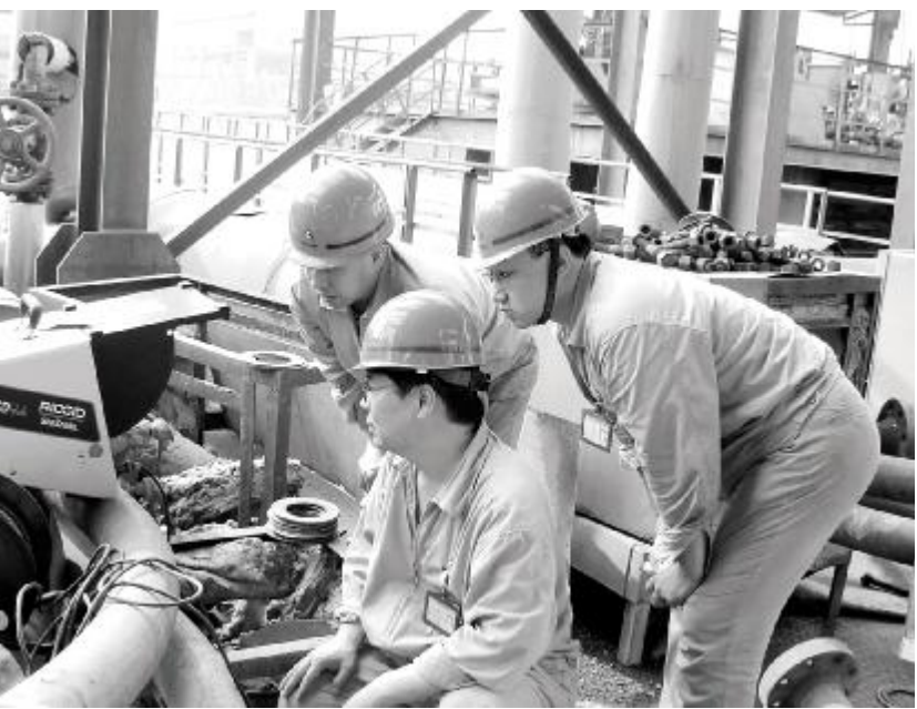
氧化铝厂管道化车间利用新进的管道内窥镜对每一条管道内结巴进行全过程跟踪排查,然后制订清洗方案,消除了过去盲目性的清洗状况。6月4日至6日,第三管道化清洗后,运行效果有了明显改变。图为管道化车间领导及相关职能人员正在用内窥镜检查管道内结巴清洗情况。 渠文广 摄影报道
