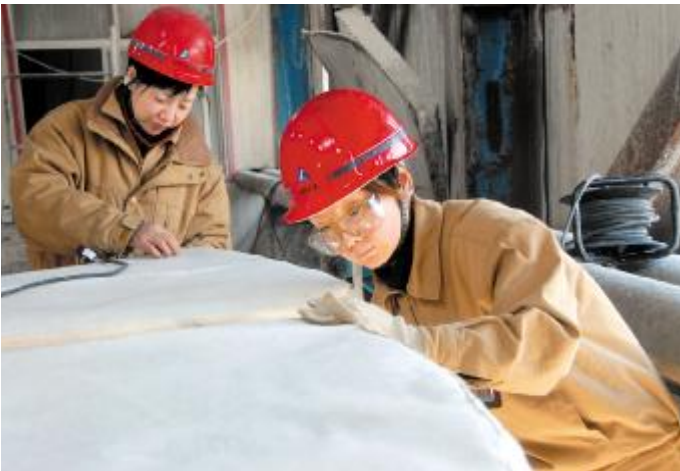
▲为自救图存,背水一战,氧化铝一厂员工精心操作,认真巡检。图为员工正在及时更换破损的过滤机滤布。 孟有光 摄影报道
