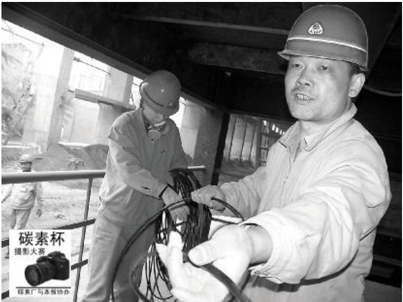
近日,氧化铝一厂电气车间大倾角南北皮带料口围出现堵塞,南北皮带需要停车,而与其相连的大倾角皮带如果继续送料会出现皮带压死现象。了解情况后,电气车间北区员工随即敷设了 230 米控制电缆,并对控制回路进行了重新设计。经过紧张施工,当天下午试车正常后交付使用。图为安装现场。袁 媛 摄影报道
