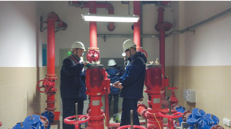
图为合肥地铁1号线云谷站消防泵给排水检查
