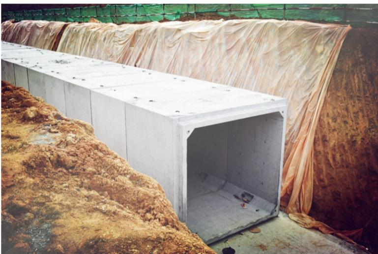
图为已经吊装就位的预制管廊 倪娜/摄
