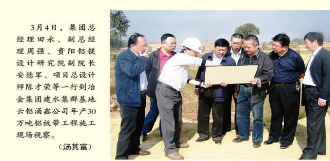
3月4日,集团总经理田永、副总经理周强、贵阳铝镁设计研究院副院长安德军、项目总设计师陈才荣等一行到冶金集团建水集群基地云铝涌鑫公司年产30万吨铝极带工程施工现场视察。(汤其富)
