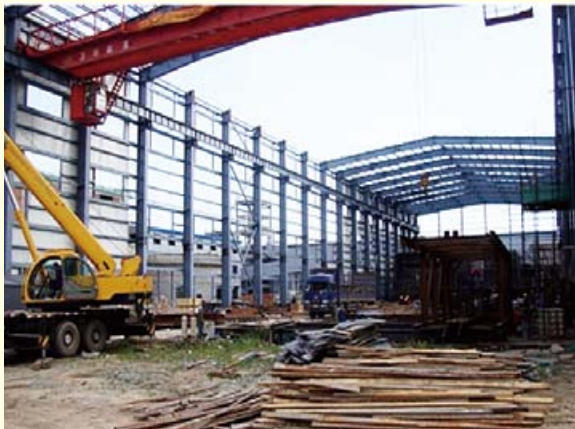
呼伦贝尔驰宏矿业公司20万吨项目 ——氧压浸出车间施工现场
