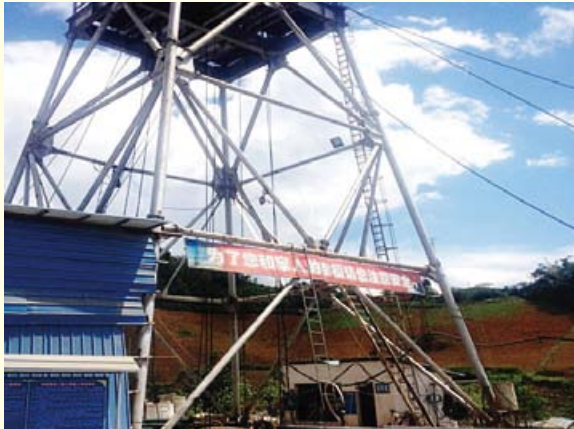
永昌铅锌公司深部资源接替工程 ——2号竖井，已完成掘进深度714米
