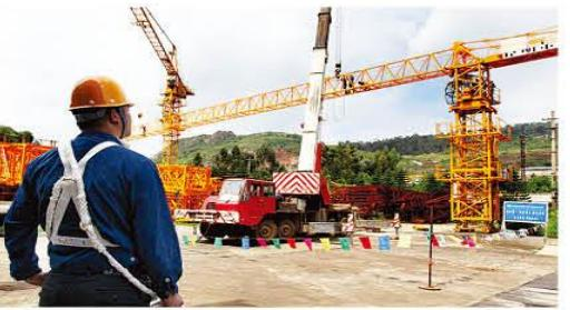
本报讯 7月6日，昆明重工首台PTC5613-G塔式起重机在塔机分厂安装成功。
