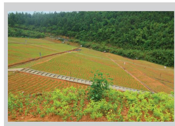
**本报讯** 7月4日，广东发恩德公司尾矿干堆场复绿工程全面完成。一眼望去，绿油油的一片草地，令人心旷神怡。据了解，该项目采用了隔离复绿施工方案，先铺薄膜、再覆土、后铺种草皮并安装喷水管，前后历时两个多月，完成覆土5000立方米，铺种草皮12000平方米。
