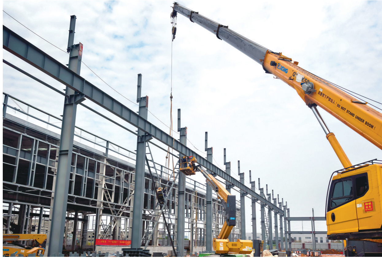
日前,铜冠建安钢构公司承建的安徽福星1500吨/年特种钢材模具制造加工项目迎来重要建设节点——2号厂房钢结构安装,标志着2号厂房主体结构施工全面铺开,项目整体建设进度将进一步加快,为各节点目标按期实现奠定了坚实基础。图为柱间支撑安装。
