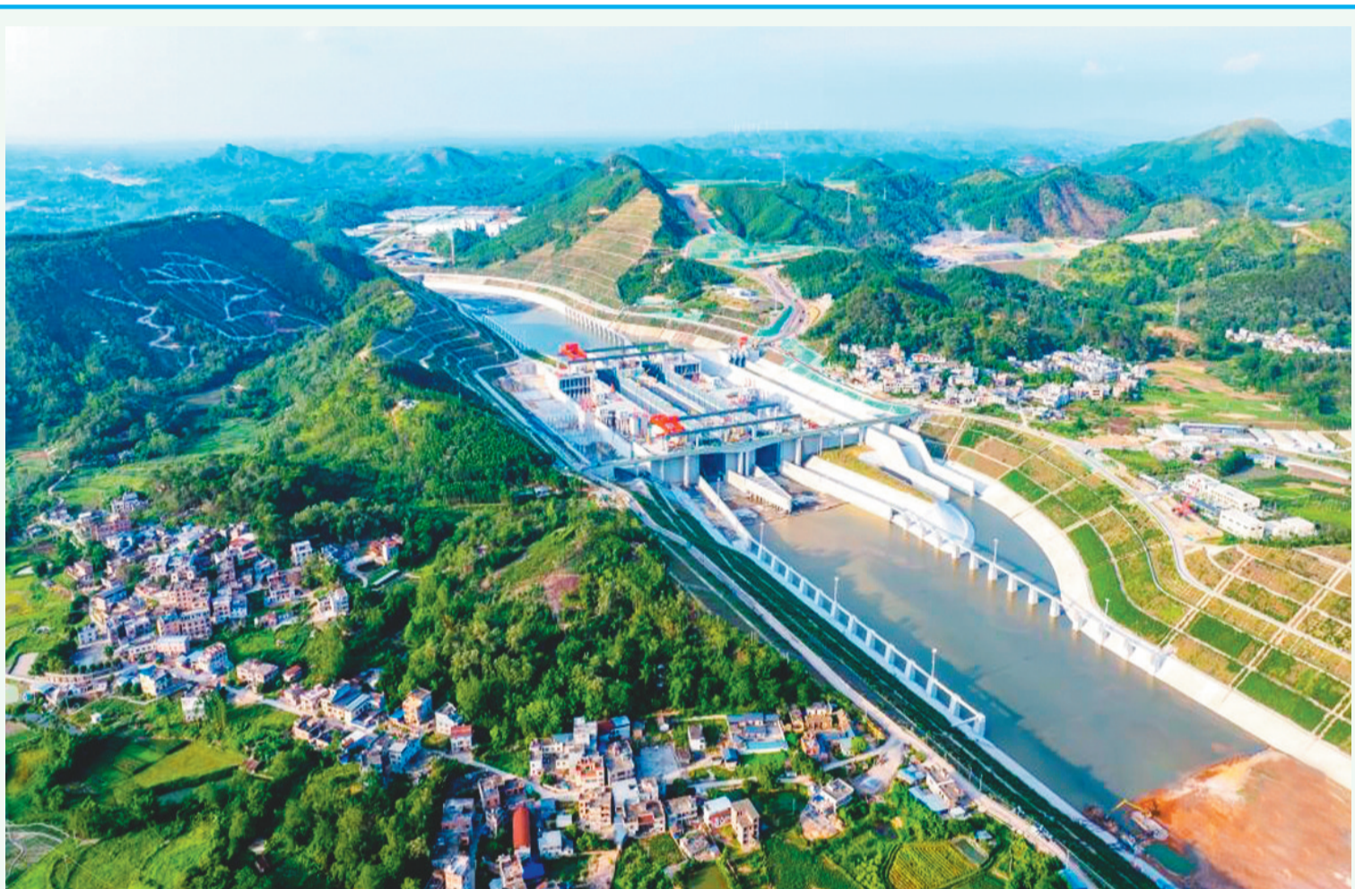
6月3日,随着平陆运河马道枢纽和企石枢纽正式开始充水,平陆运河全线通水,全面进入有水调试阶段。平陆运河是西部陆海新通道骨干工程,全长134.2公里,北起广西横州市平塘江口,经灵山县陆屋镇,沿钦江进入北部湾,作为新中国成立以来我国第一条国家层面统筹的通江达海的运河工程,平陆运河可通航5000吨级船舶,将于今年9月通航。
