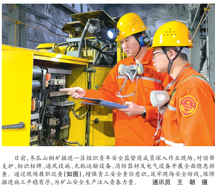
日前,冬瓜山铜矿掘进一区组织青年安全监管岗成员深入作业现场,对顶帮支护、标识标牌、通风设施、无轨运输设备、消防器材及电气设备开展全面隐患排查。通过现场履职巡查(如图),增强青工安全意识,筑牢现场安全防线,保障掘进施工平稳有序,为矿山安全生产注入青春力量。
