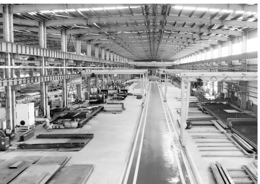
图为铜冠建安钢构公司生产车间。
