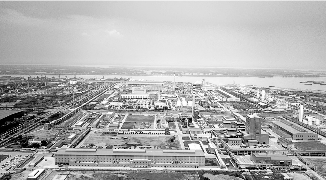
图为铜冠建安公司承建的铜陵有色铜冶炼工艺技术升级改造项目(“奥炉改造”)项目。
