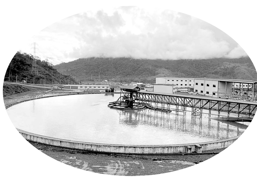
图为厄瓜多尔米拉多铜矿2000万吨年采选项目——100米浓密池。
