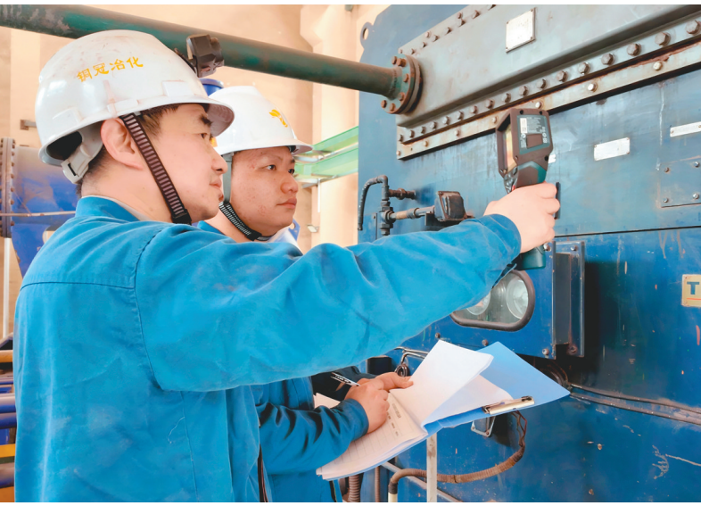
铜冠冶化分公司深化预知维修模式,利用智能巡检系统与区域专巡、设备点检以及岗位巡检的“听摸测看”相结合,提前预判处理潜在设备隐患,保持硫酸系统高效稳定运行。图为日前该分公司硫酸车间员工在对二氧化硫主风机进行岗位巡检。 通讯员 胡永斌 马凯 摄
