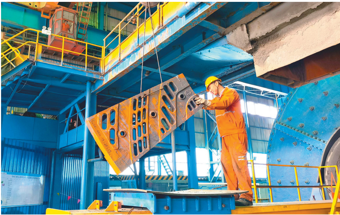
近日,冬瓜山铜矿选矿车间半自磨机衬板圆满完成更换工作。该车间各班组协同作业,共完成了145块衬板、花板及角衬板拆除与安装作业,为设备稳定运行筑牢基础。图为起重人员正精准配合行车吊装花板再利用机械手高效推进部件就位。
