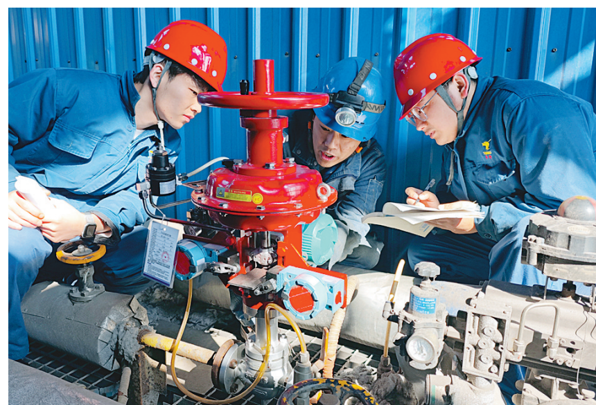
日前,动力厂维修车间员工聚集在供暖调节阀旁,正在对阀体控制系统进行最后的精细调试(如图)。大家各司其职,密切配合,细致校准各项参数,全力保障设备稳定运行与生产安全。
