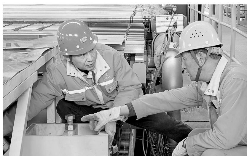
今年以来,铜冠(庐江)矿业公司持续优化细砂项目工艺流程与设备运行,着力提升系统运行效率,全力推动项目进入全面达产达效阶段。图为近日该项目两名员工正在检查设备液压泵润滑油加注情况。
