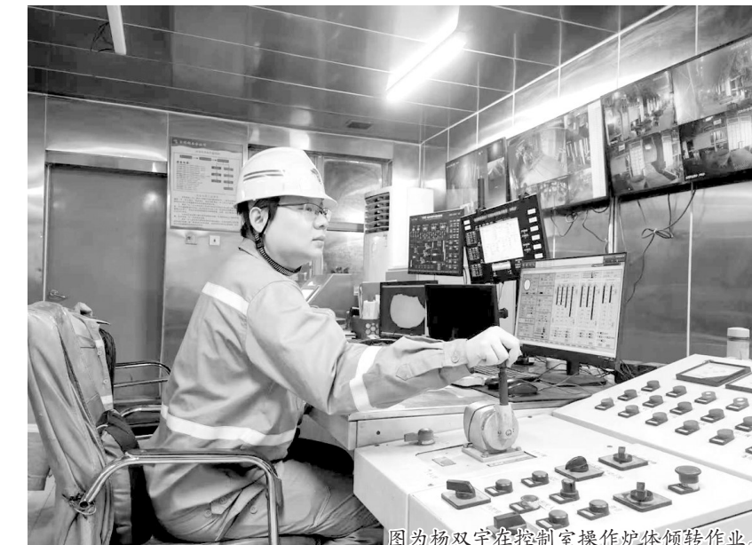
图为杨双宇在控制室操作炉体倾转作业。
