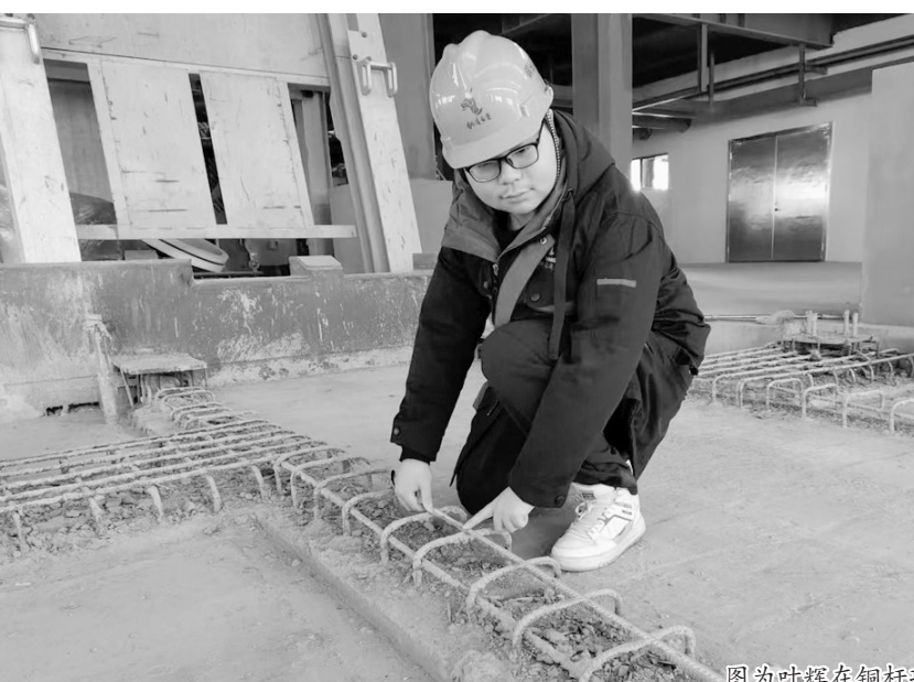
图为叶辉在铜杆项目测量箍筋间距。
