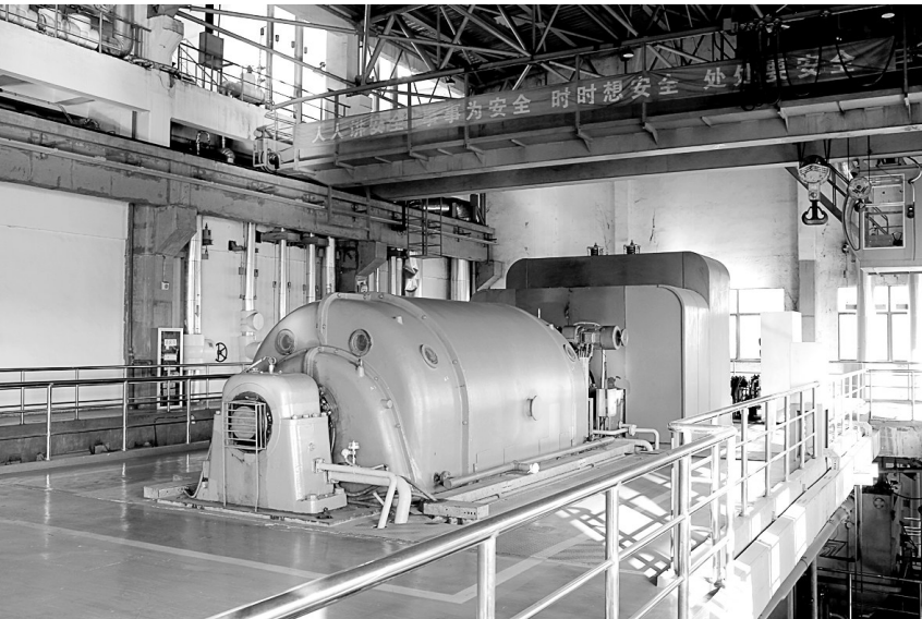
图为动力厂热电车间汽轮发电机。
