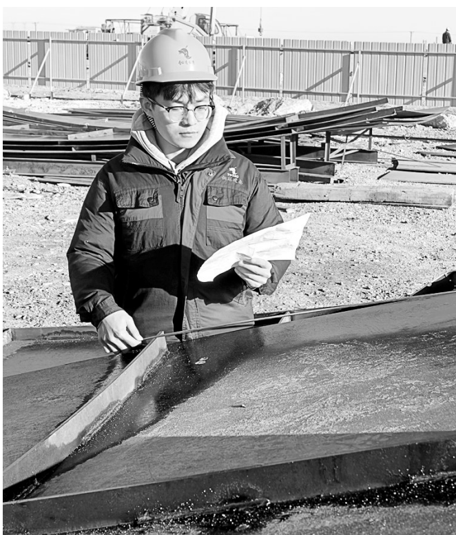
图为刘伟伟在营口酸罐项目上测量顶罐的筋板尺寸。
