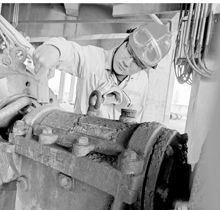
图为项全胜对选矿53米浓密机渣浆泵进行日常点检。
