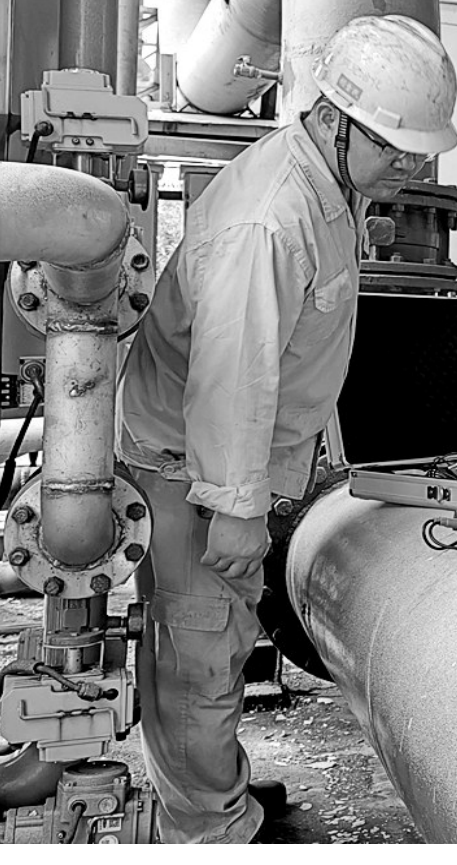
承建并启动实施的第三个尾矿库治理项目。
