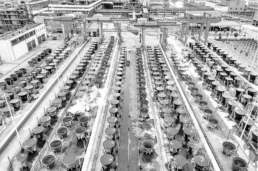
图为金冠铜业分公司奥炉厂区渣液冷却智能化作业场景。
