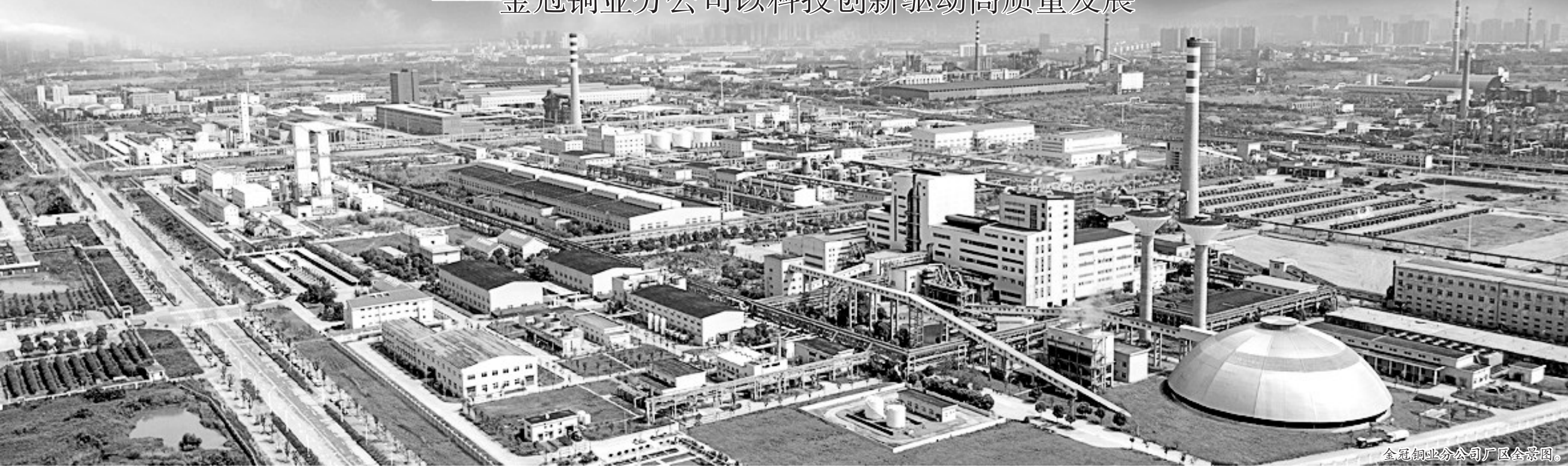
金冠铜业分公司厂区全景图。
