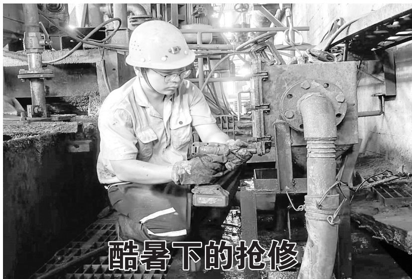
近日,天马山矿业公司职工冒着酷暑,高效完成强磁机关键进水管道故障检修(如图),全力保障核心生产设备在高温下的安全稳定运行。
