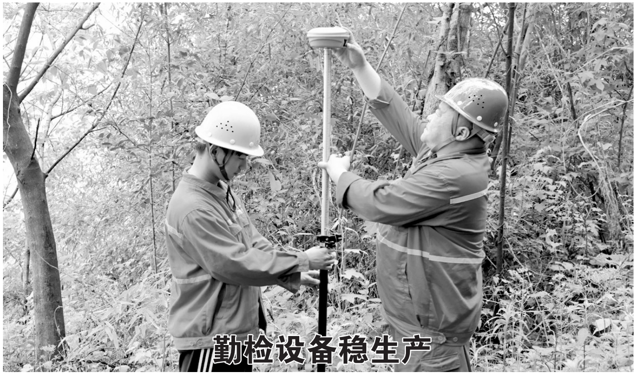
连日来,矿产资源中心测绘人员头顶烈日,赴天马山矿业公司进行地表钻孔测量放点工作(如图),确保项目有序推进。
