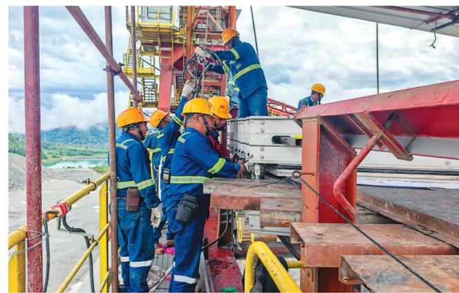
近日,铜冠建安公司承建的米拉多铜矿废石生产线,8月份处理废石量达363.23万吨,不仅刷新该生产线单月处理量历史纪录,更较去年同期单月最高处理量实现18.8%的显著增长,为后续产能释放奠定坚实基础。图为该生产线维修人员正在组装硫化机,为生产线持续稳定运转提供有力支撑。通讯员 赵旻 王顺 摄
