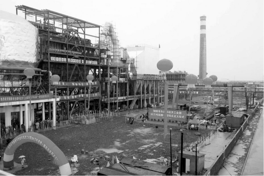
图为该分公司80万吨硫酸项目一期点火仪式。
