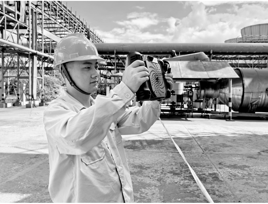
图为水海华利用声学成像仪检测转化器漏点。
