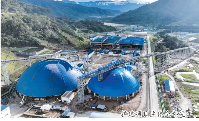
扩建项目主体会部完工。
