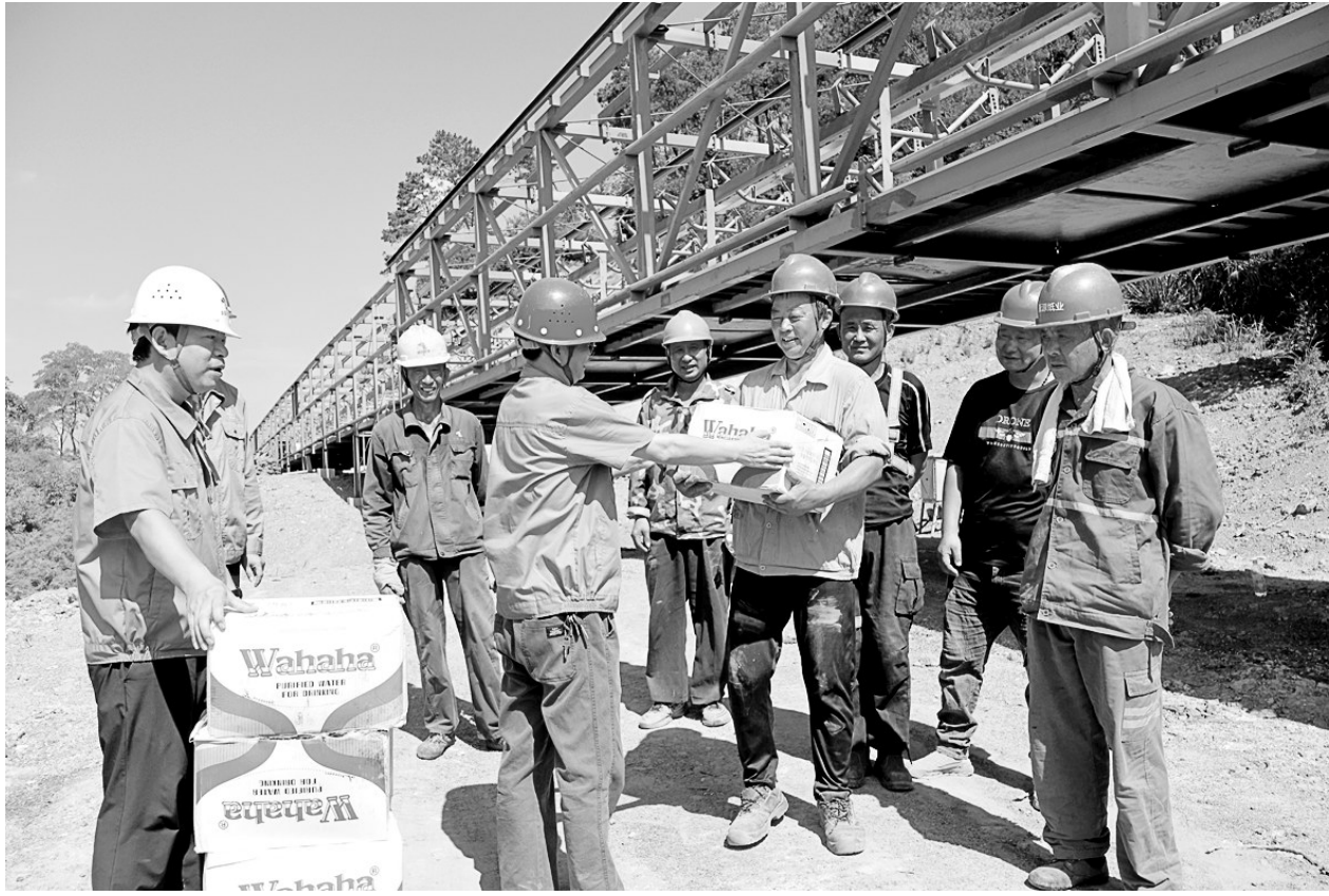
近期,金磊矿业公司开展了高温慰问,为坚守在皮带廊道施工现场的项目部员工送去防暑降温物资。图为该公司工会向项目部员工发放矿泉水。
