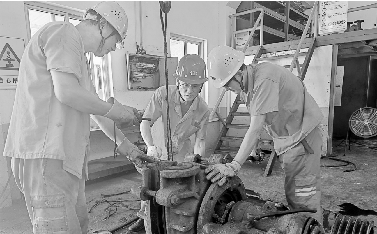
图为余同光(中)与工友正在进行废旧渣浆泵修复工作。
