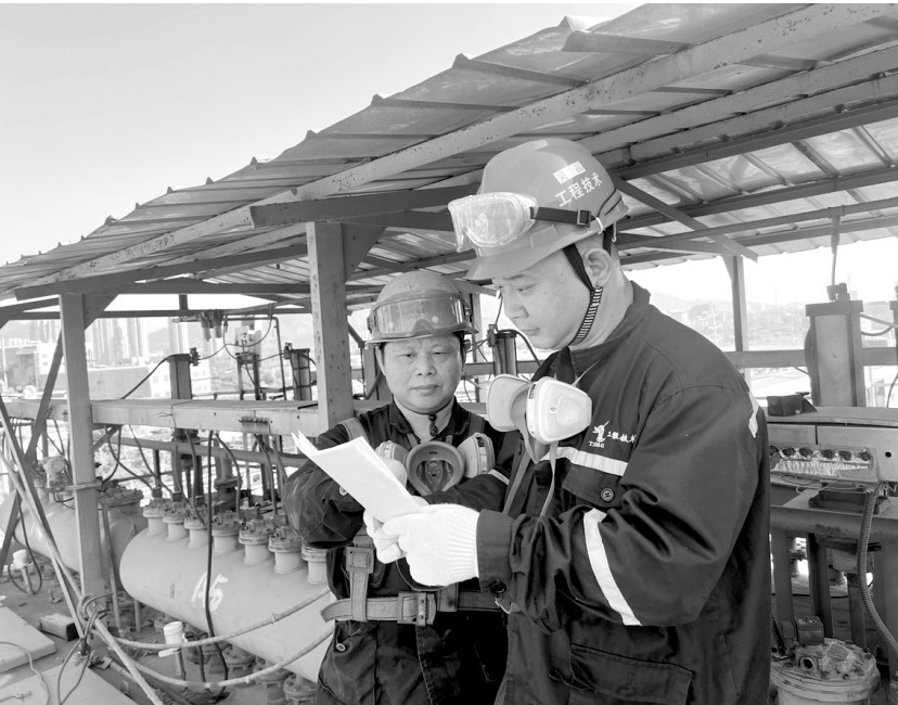
图为吴晶(右)正在进行施工现场安全确认。
