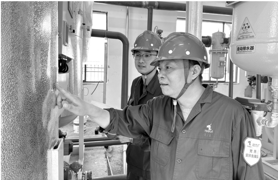
图为周大慧(右)在现场指导新空压机系统安装调试工作。
