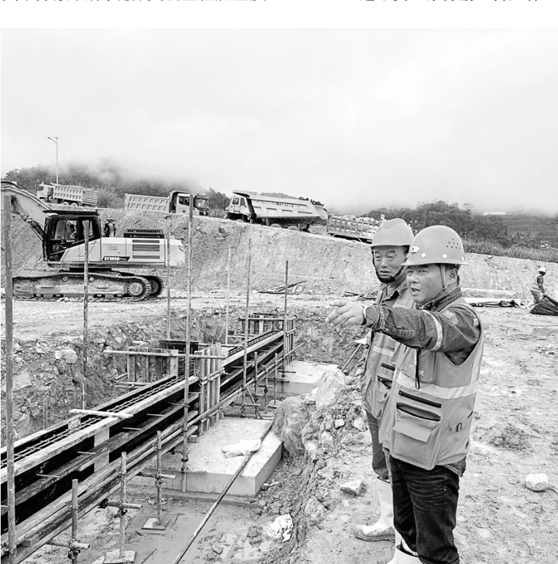
图为朱运涛(右)在项目部维修车间工地安排工作。
