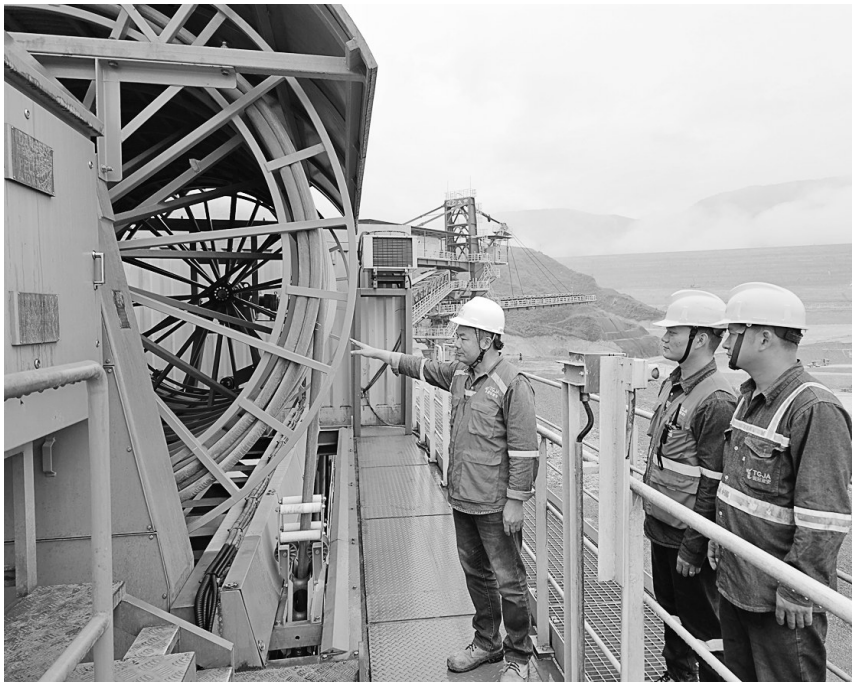
图为陈昌胜(左一)在现场指导设备日常巡检。
