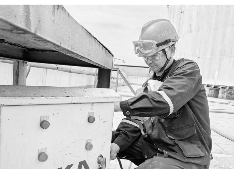
图为陆庭正在进行防腐机器人作业前准备工作。
