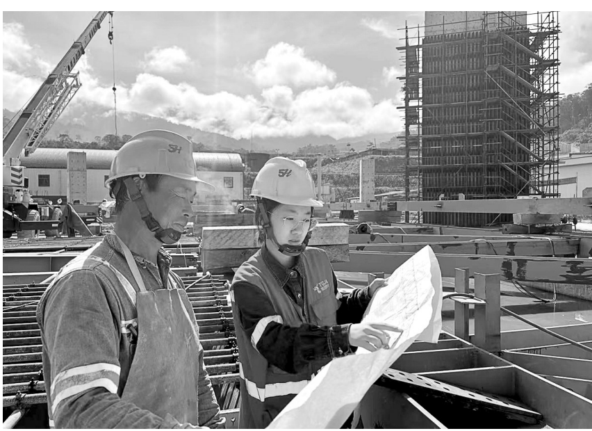
图为张莉(右一)在施工现场。
