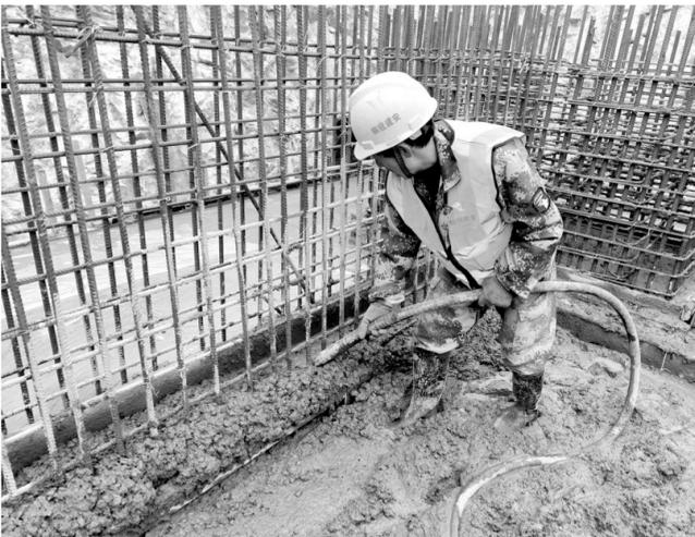
近日,铜冠建安公司第一事业部承建的全通铜业铜冶炼工艺升级搬迁改造项目二期工程北附跨地坑底板顺利完成混凝土浇筑任务(如图)。此次浇筑方量780平方米,历时10小时。项目团队采取双重技术措施,实施不间断作业模式,确保混凝土浇筑连续性和质量稳定性。
