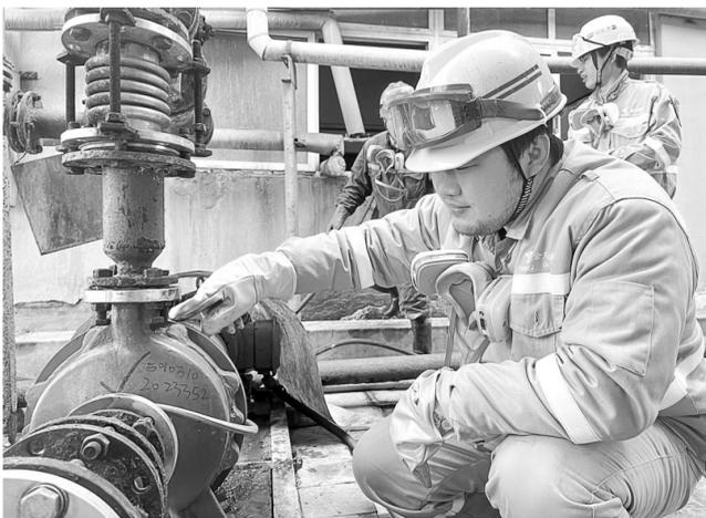
近日,金冠铜业分公司双闪硫酸车间党员先锋队结合生产实际,组织党员及入党积极分子开展巡检,对脱硫和净化区域的重点设备、管道、标识标牌等进行了隐患排查。图为工艺专职正在检查净化铅压滤机给料泵。
