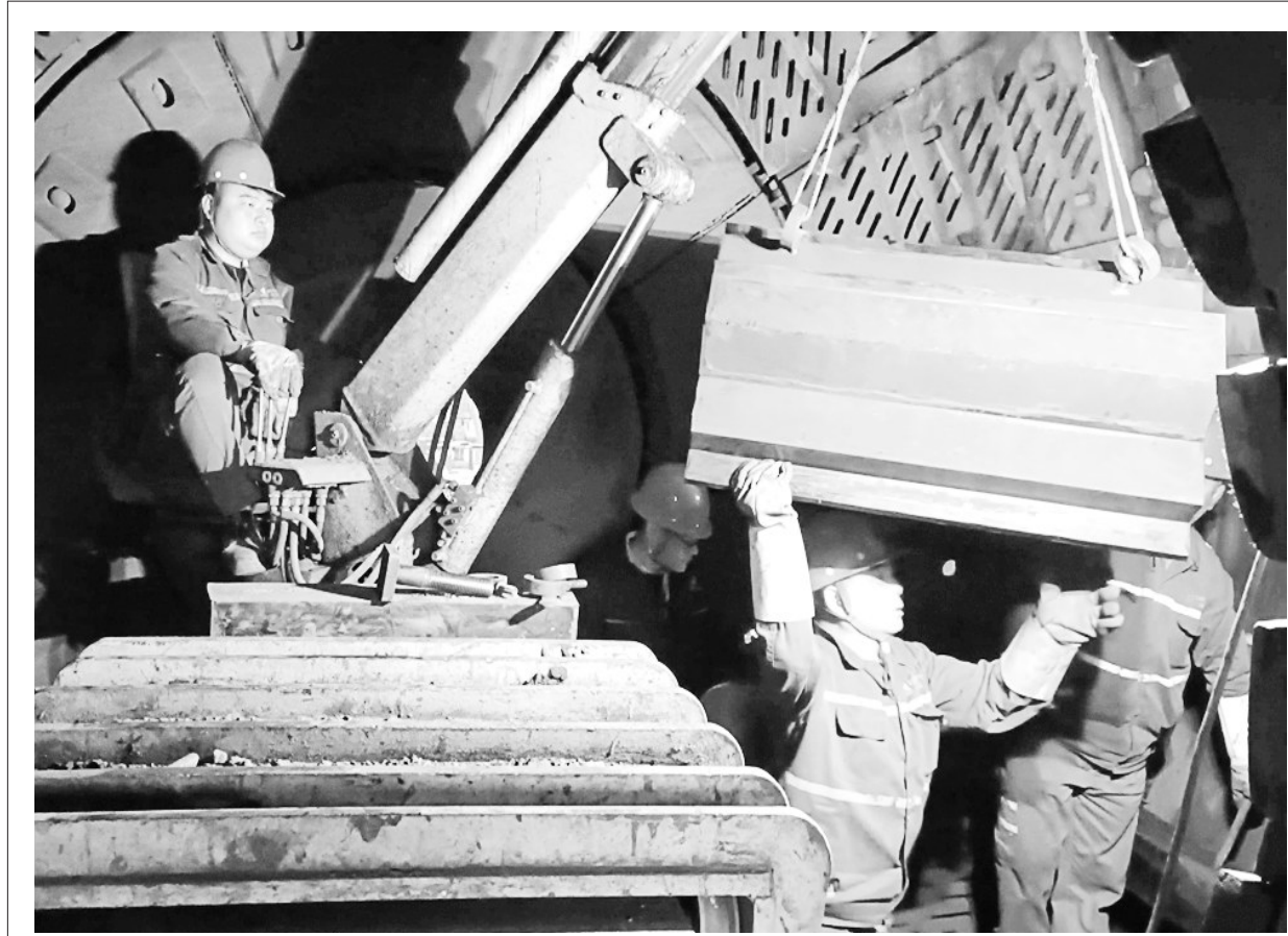
3月13日，铜山铜矿分公司利用系统设备矿间隙完成了选矿车间半自磨进料外圈端盖衬板及筒体衬板的更换。图为工作现场。
