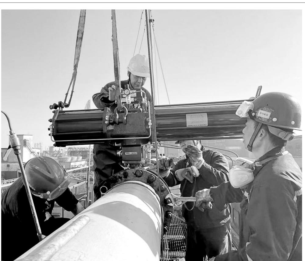
铜冠冶金分公司球团车间针对焦油堵塞腐蚀炉煤气调节阀等问题,采取预防措施,及时除焦修复保养阀体,让“老”设备焕发“新”生机。图为日前检修人员在安装修复保养后的焦炉煤气调节阀。
