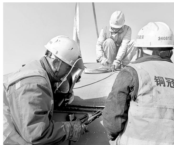
连日来,铜冠建安安装公司承接的金冠铜业12万吨酸罐制作安装项目如火如荼建设中。该公司酸罐项目部和施工班组全力克服冬季现场施工困难,确保施工进度“不断档”、重点建设物资“不断供”。图为近日该公司项目班组吊装顶板。
