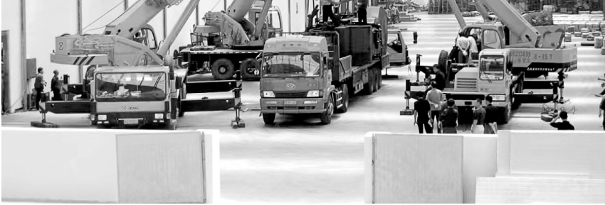
图为4台120吨吊机正在吊装Φ50毫米缴球机。
