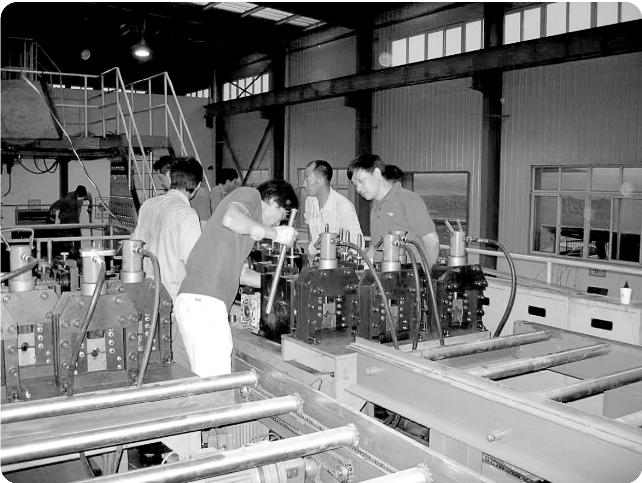
图为扩建项目投产前夕技术人员正在对磷铜杆牵引校直系统进行调试。
