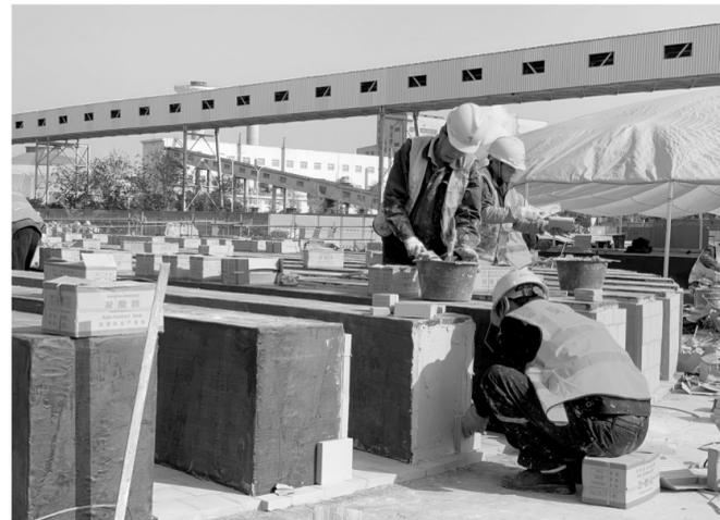
11月25日,冠冠建安公司第一事业部承建的12万吨酸罐防水防腐项目正在加快推进基础工程施工进度。为保障工期,项目部开启了夜间施工模式,搭设雨棚确保雨天不间断施工,为顺利交付打下基础。图为防腐项目部班组成员正在给B区酸罐基础部位铺设耐酸瓷板。
