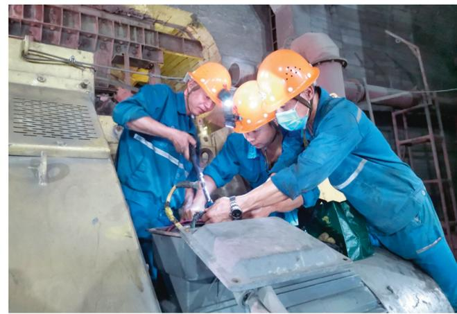
安庆铜矿机运工区电修班始终坚持安全为先、生产为要的原则,积极组织班组员工奋战在抢修一线,保障了该工区运输、破碎、提矿等生产环节安全高效运行,为矿山安全生产打下良好基础。图为中秋假日期间电修班员工正在对井下负922米破碎机接线桩进行紧急抢修。
