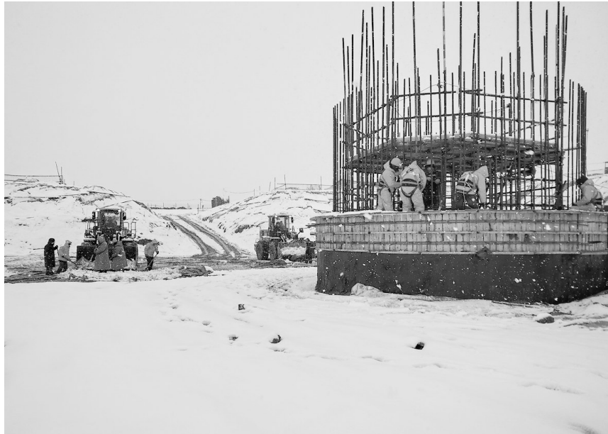
图为铜冠矿建公司哈萨克斯坦VCM项目在雪天的施工现场。
