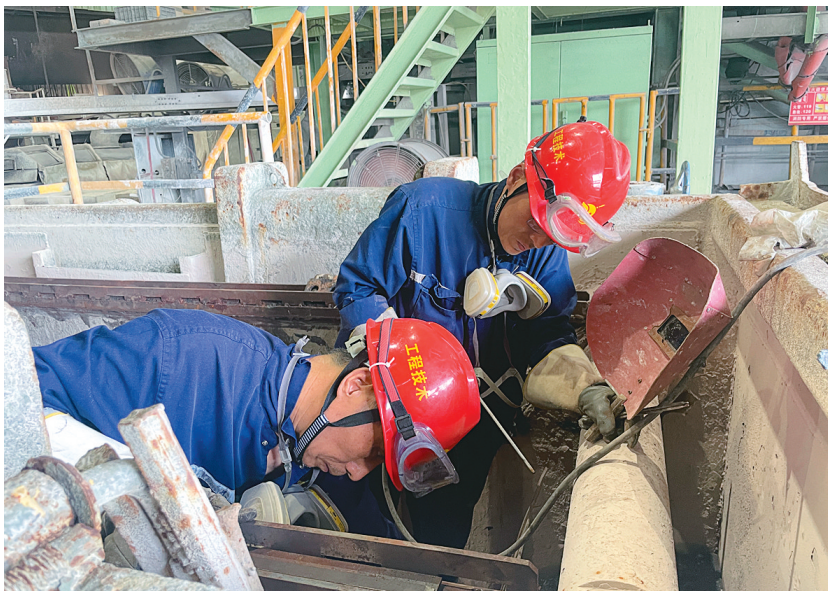
工程技术分公司积极应对高温天气造成机器设备故障率升高情况,执行周期性检修及联合点检,安排检修人员进行每日设备排查,提前发现并及时处理故障隐患,确保业主方安全稳定生产。图为近日该公司金陵项目部机械班检修人员对金陵铜业公司双圆盘A盘水槽支架及链条进行整体更换场景。 通讯员 陈陈摄
