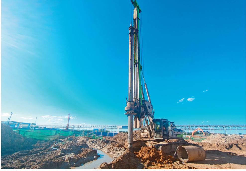
日前,铜冠建安公司第一建筑工程事业部承建的赤峰金通铜业有限公司铜冶炼工艺升级搬迁改造项目二期工程—II期酸库桩基施工顺利完成。施工以来,该事业部赤峰金通二期项目部按照业主要求的工期节点,完成了456根(冲)孔灌注桩的浇筑,为项目后续工作的开展奠定了基础。图为桩基混凝土浇筑现场。
